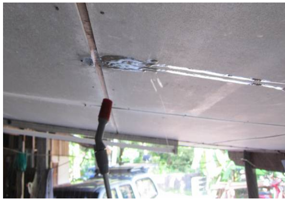
ภาพที่ 3.2.2-1 แนวกระเบื้องแผ่นเรียบและแนวตะปูที่ทำการยึดกระเบื้องแผ่นเรียบกับ
