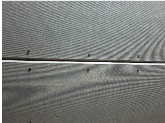
ภาพที่ 3.2.2-1 แนวกระเบื้องแผ่นเรียบและแนวตะปูที่ทำการยึดกระเบื้องแผ่นเรียบกับ
