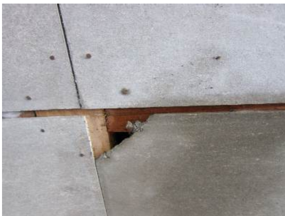
ภาพที่ 3.2.2 - 6 บริเวณที่ต้องระวังเป็นพิเศษคือ มุมผ้า เนื่องจากจะมีตะปูยึดหลายตัว
