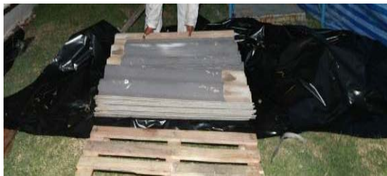
ภาพที่ 3.2.1-8 นำพาส์ตามด้วยแผ่นพลาสติกทึบอย่างน้อย 2 แผ่น และนำกระเบื้องมุงหลังคา วาง จัดการห่อหุ้มให้เรียบร้อย
