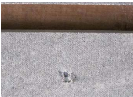
ภาพที่ 3.2.2 – 4 หากหัวตะปูไม่หลุดสามารถเห็นได้ว่าหัวตะปูจะโผล่ออกมา จากนั้นใช้คีม คีมและดึงตัวตะปูออกได้
