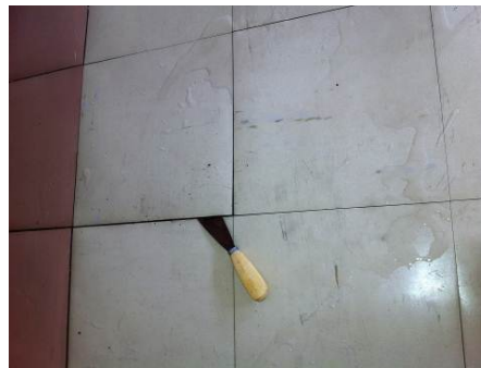
ภาพที่ 3.2.4-2 ใช้เกียงหรือสว่านเจาะแนวแผ่นกระเบื้องปูพื้น
