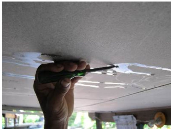
ภาพที่ 3.2.2-3 ใช้ส่วที่มีความคมจ่อหัวตะปูและใช้ค้อนตอกเบาๆ หัวตะปูจะถูกตัด
