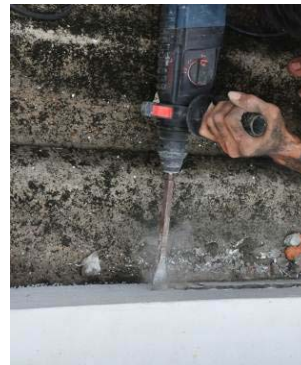
ภาพที่ 3.2.1-3 การใช้สว่านเจาะคอนกรีตที่ยึดระหว่างโครงสร้างกับกระเบื้องมุงหลังคา
