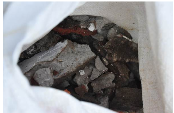
ภาพที่ 3.2.1-4 การเก็บเศษคอนกรีตใส่กระสอบหรือถุงปุ๋ยเพื่อนำไปทิ้ง
