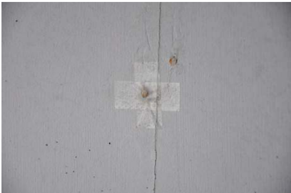
ภาพที่ 3.2.3-4 การติดเทปใสที่หัวตะปู
