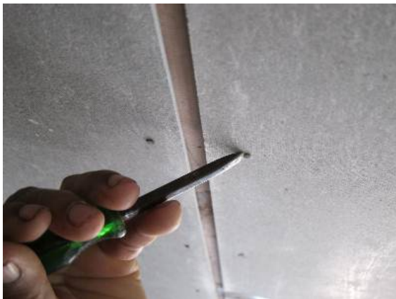
ภาพที่ 3.2.2-3 ใช้ส่วที่มีความคมจ่อหัวตะปูและใช้ค้อนตอกเบาๆ หัวตะปูจะถูกตัด
