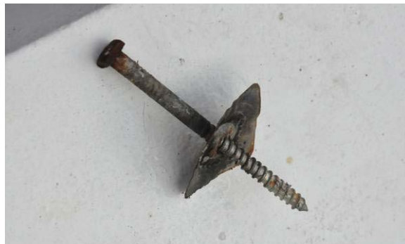
ภาพที่ 3.2.1-5 ใช้คีมหนีบและถอดตะปูออกจากกระเบื้องมุงหลังคา
