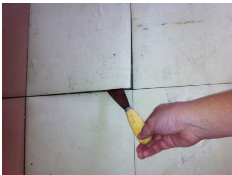
ภาพที่ 3.2.4-3 ใช้เกียงหรือสว่านเจาะแนวแผ่นกระเบื้องปูพื้น
