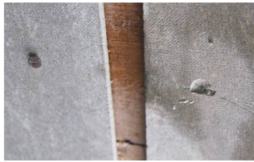
ภาพที่ 3.2.2 – 4 หากหัวตะปูไม่หลุดสามารถเห็นได้ว่าหัวตะปูจะโผล่ออกมา จากนั้นใช้คีม คีมและดึงตัวตะปูออกได้
