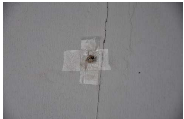
ภาพที่ 3.2.3-7 ภายหลังจากการตอกตะปูเสร็จ เรียบร้อยแล้ว
