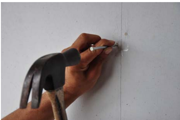
ภาพที่ 3.2.3-6 การตอกด้วยตะปูคอนกรีต เพื่อให้ตะปูทะลุผนังกันห้องลงไปที่โครงสร้างไม้
