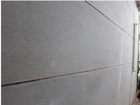
ภาพที่ 3.2.2-1 แนวกระเบื้องแผ่นเรียบและแนวตะปูที่ทำการยึดกระเบื้องแผ่นเรียบกับ
