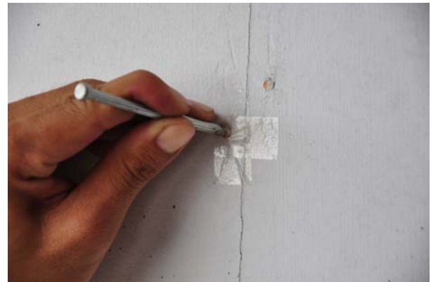
ภาพที่ 3.2.3-5 การเตรียมใช้ตะปูตอก คอนกรีตตอกย้าที่หัวตะปูยึดผนัง
