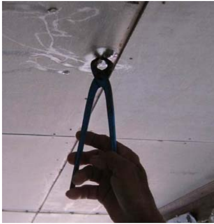
ภาพที่ 3.2.2 – 4 หากหัวตะปูไม่หลุดสามารถเห็นได้ว่าหัวตะปูจะโผล่ออกมา จากนั้นใช้คีม คีมและดึงตัวตะปูออกได้
