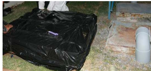
ภาพที่ 3.2.1-8 นำพาส์ตามด้วยแผ่นพลาสติกทึบอย่างน้อย 2 แผ่น และนำกระเบื้องมุงหลังคา วาง จัดการห่อหุ้มให้เรียบร้อย
