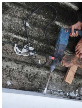
ภาพที่ 3.2.1-3 การใช้สว่านเจาะคอนกรีตที่ยึดระหว่างโครงสร้างกับกระเบื้องมุงหลังคา
